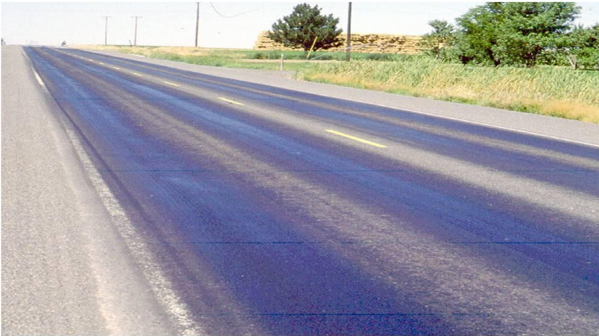
ASFALT: „POCENIE SIĘ” W ŚLADACH KÓŁ
