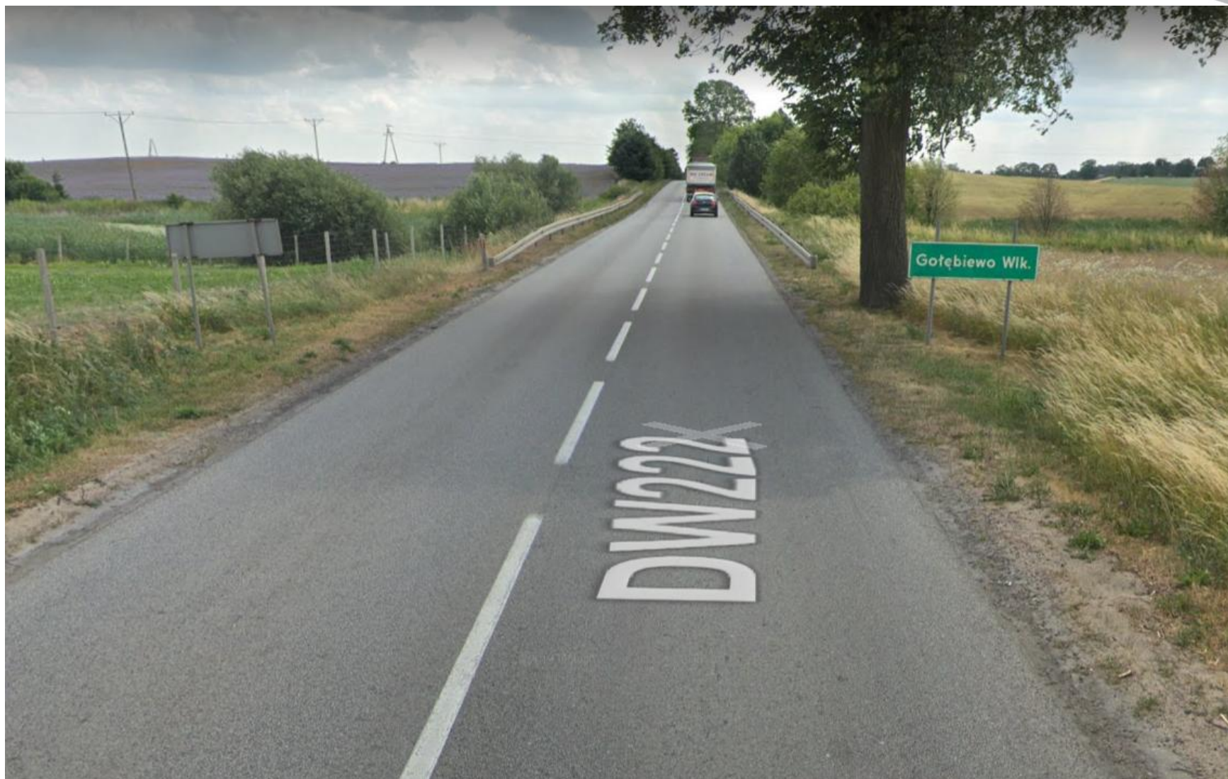
Stan odcinka w czerwcu 2018 (15 lat po przebudowie)
