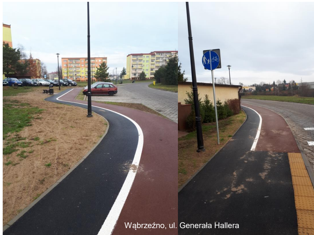
Rysunek 4. Nawierzchnia ciągu pieszo-rowerowego wzdłuż DK 13 po trzech latach od oddania do użytku.
