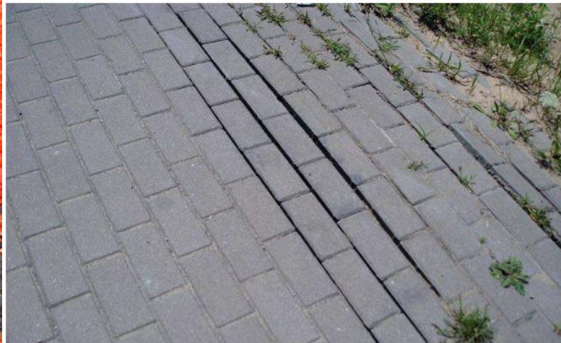
Rysunek 3. Typowe dla dróg z kostki szczeliny podłużne są niebezpieczne dla wąskich kół roweru. DK 61, Zegrze Północne.
