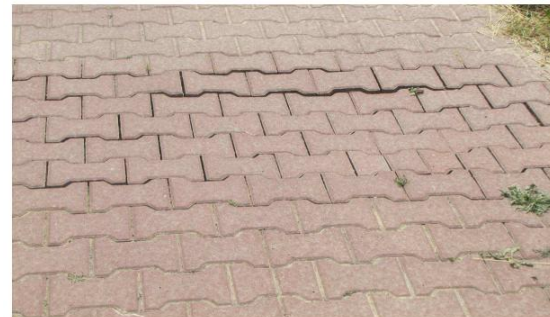
Rysunek 5. Typowe zapadnięcie nawierzchni „rozbiaralnej” po wykonaniu przyłącza. DK 5 w okolicy Stężewa.
