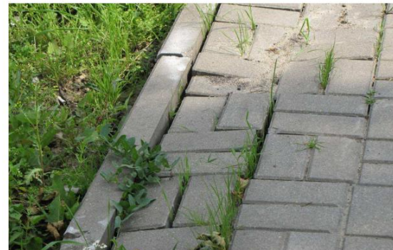
Rysunek 6. Tak często w praktyce wygląda odtworzenie nawierzchni z kostki betonowej po zakończeniu robót. DK 2 w okolicy Błonia.
