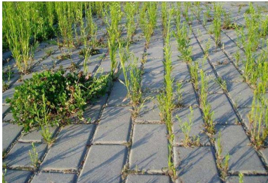
Rysunek 2. Utrzymanie dróg dla rowerów z kostki wymaga starannego usuwania roślinności ze szczelin pomiędzy kostkami. Przejście DK 61 przez Bargłów Kościelny.
