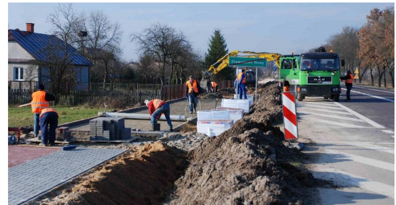
DK2 Sławacinek Budowa ciągu pieszo-rowerowego
