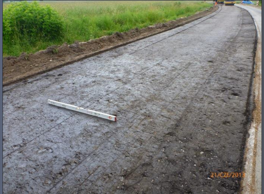
Fot. 2. Podbudowa wykonana w technologii recyklingu głębokiego na zimno z asfaltem spionionym po wstępnym zagęszczeniu
