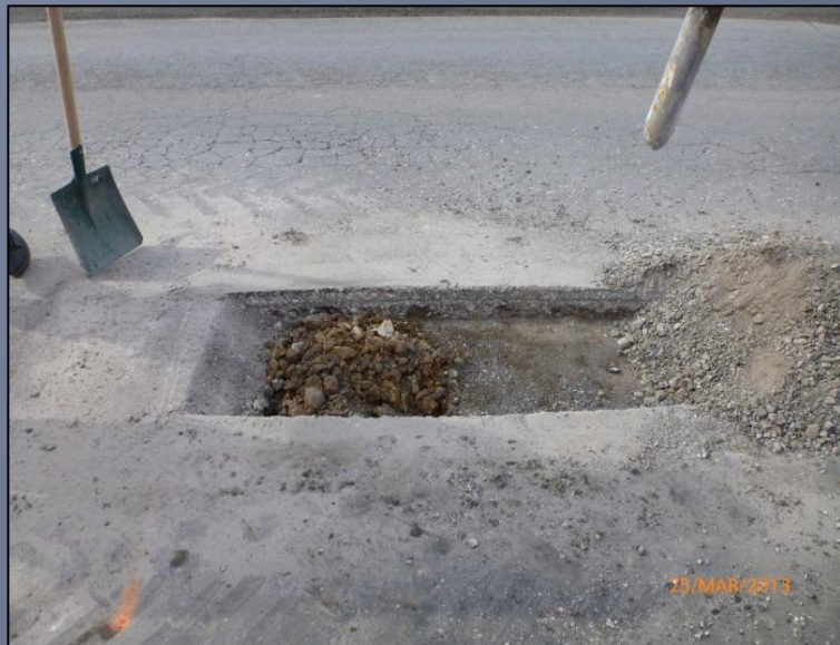
Fot. 3. Ocena konstrukcji nawierzchni – pobieranie próbek
