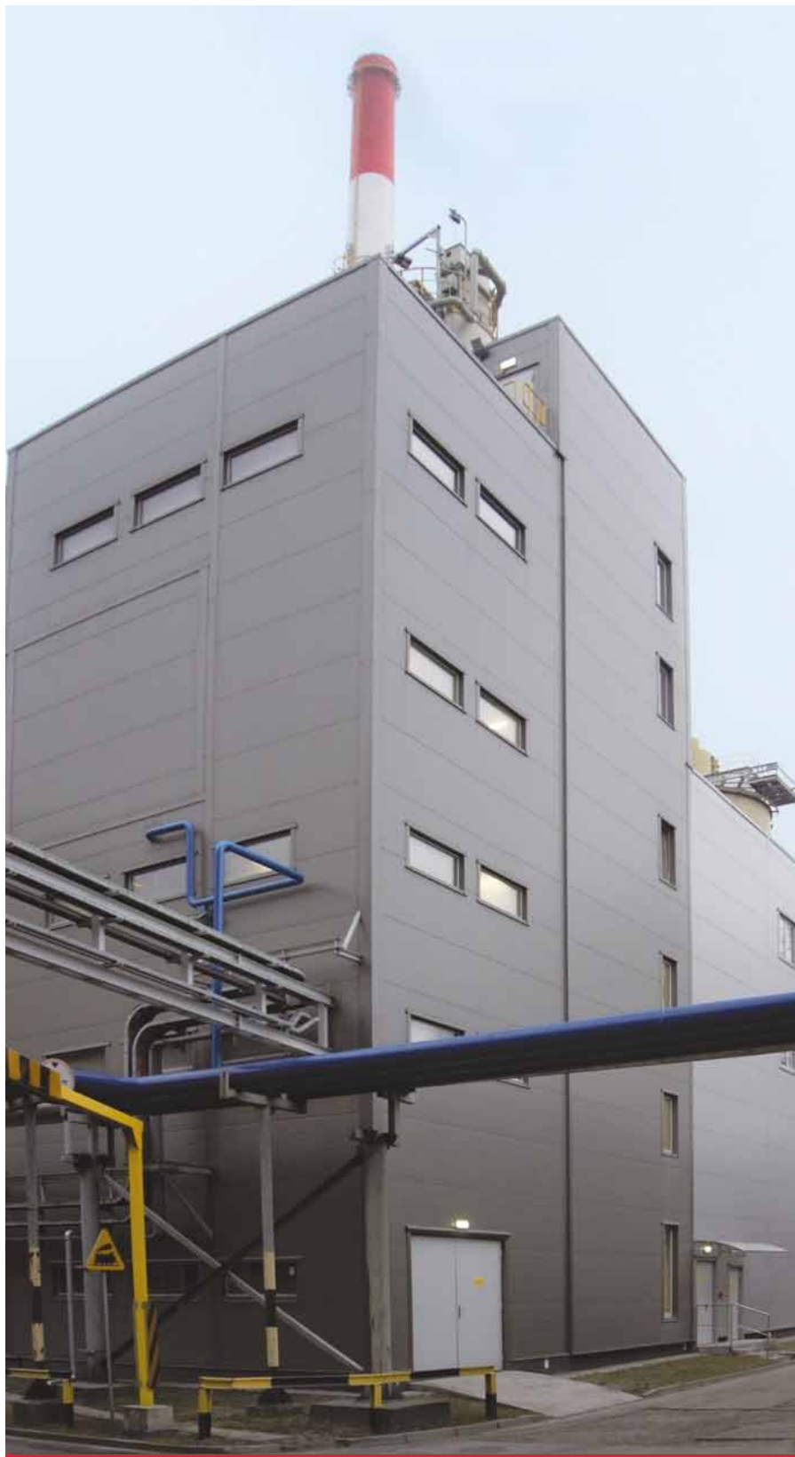
W Elektrociepłowni Siekierki od grudnia 2017 r. działa Zakład Separacji Popiołów produkujący tzw. popiół lotny do betonu...
