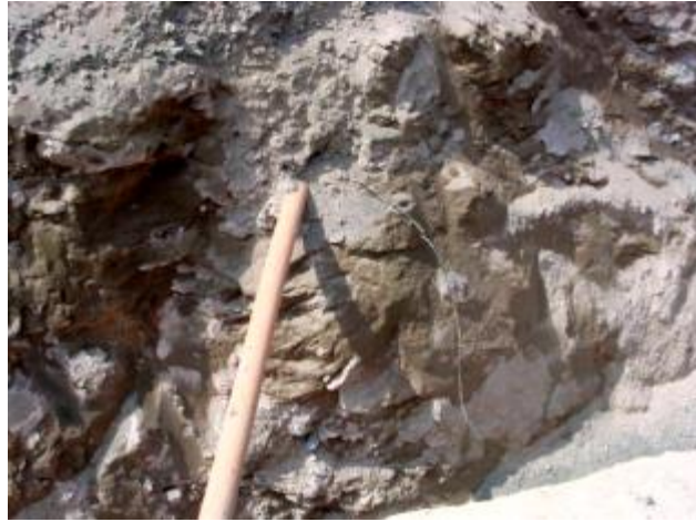
Rozerwanie linki stalowej
