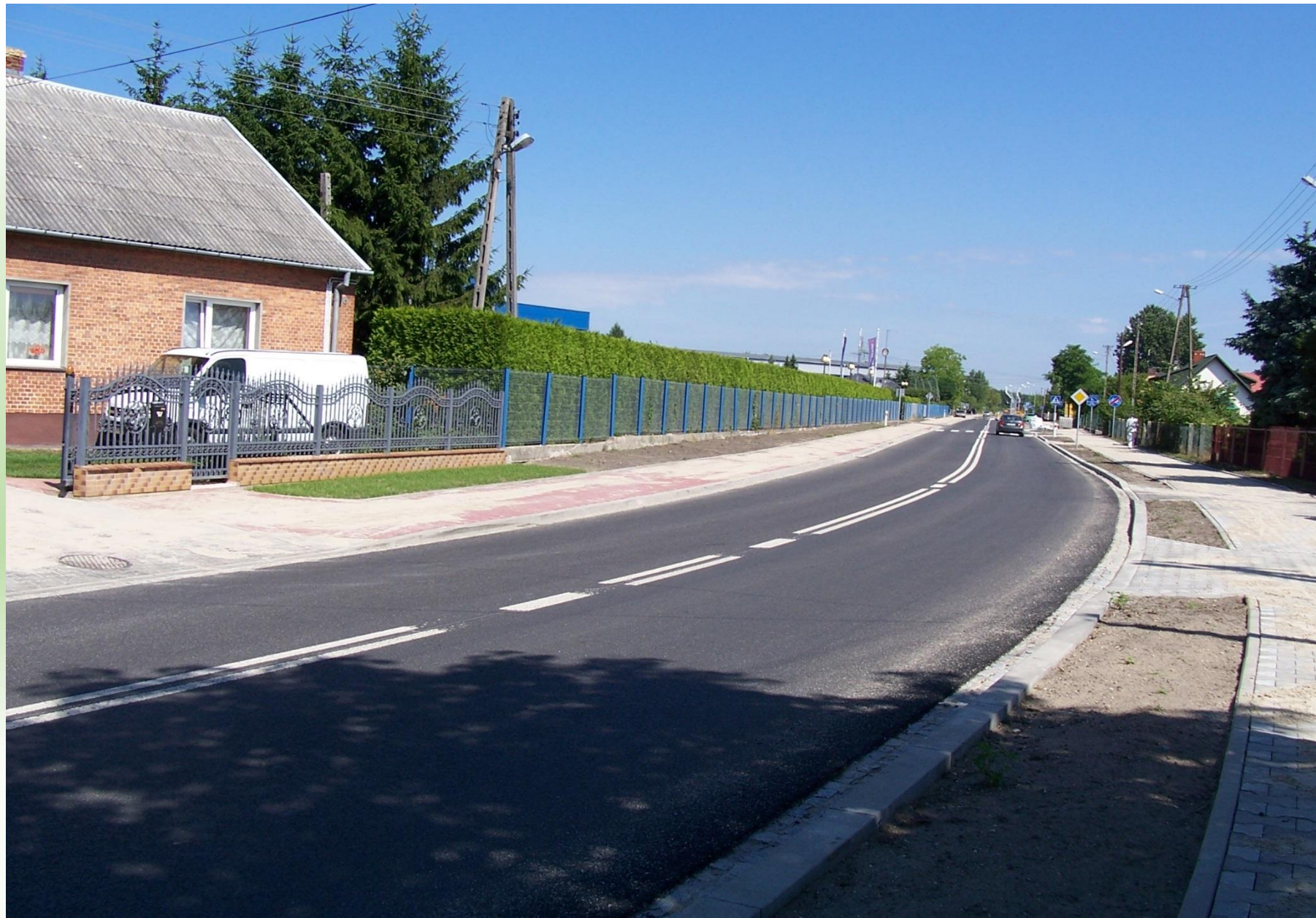
Fot. 5 ciąg rowerowy wzdłuż DW 742
