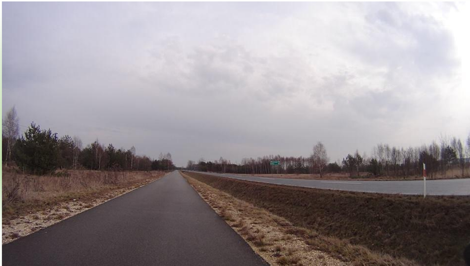
Fot. 4 Droga rowerowa wzdłuż DW 786
