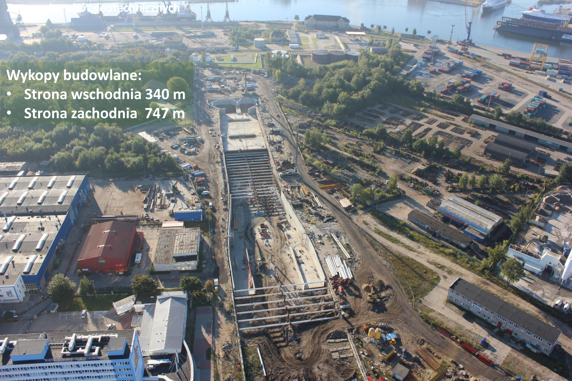
Tunel pod Martwą Wisłą, strona zachodnia
