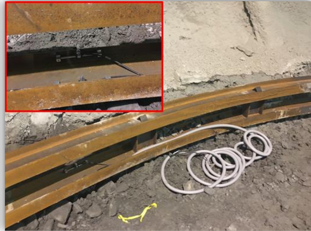
INSTALACJA TENSOMETRÓW NA ŻEBRZE STALOWYM
