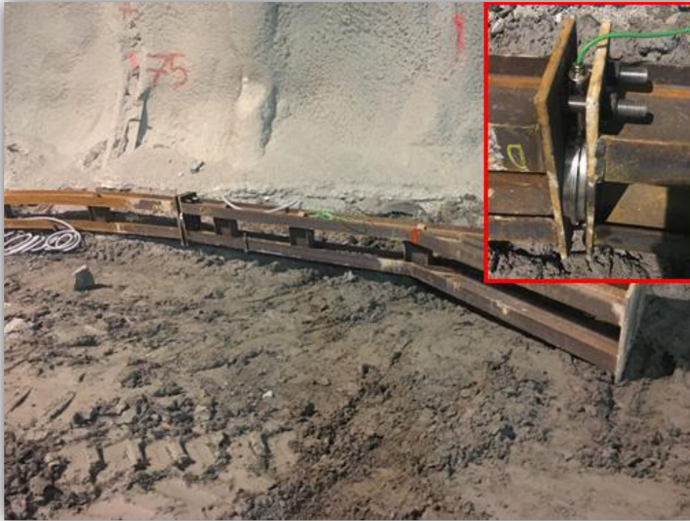
INSTALACJA WSKAŹNIKA OBCIĄŻENIA W ŻEBRZE STALOWYM
